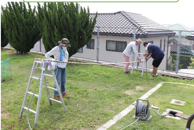
流しそうめん台の取付け その①
